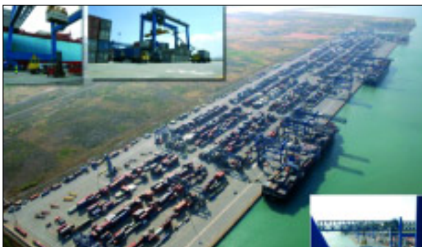
Terminal de contenedores de Cagliari
